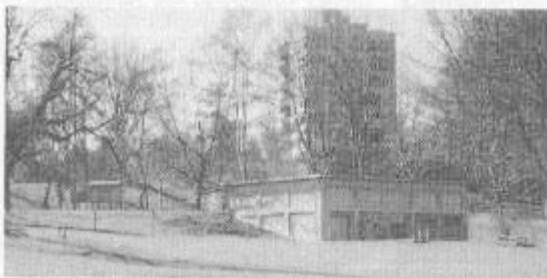
Im 2. Quartal 2006 werden die Bauarbeiten des neuen Trinkwasser-Reservoirs auf dem Bruderholz beginnen. Foto: zVg
